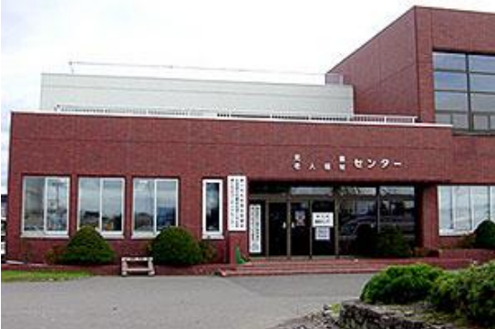
深川市総合福祉センター
